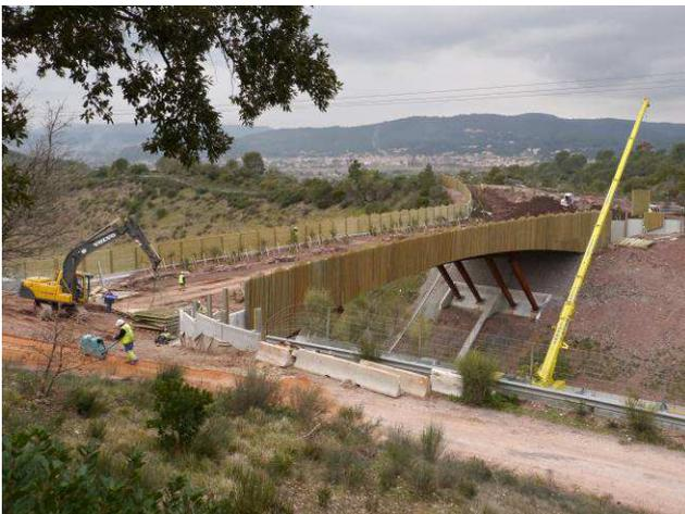
Construction d'un passage supérieur spécifique, de 15 m de largeur au centre, sur l'autoroute – A57, Pr 36,2 – 20 ans après la mise en service de l'infrastructure (Positionnement de l'ouvrage par O.G.E.-V. Vignon pour Escota), le 27 mars 2013.
